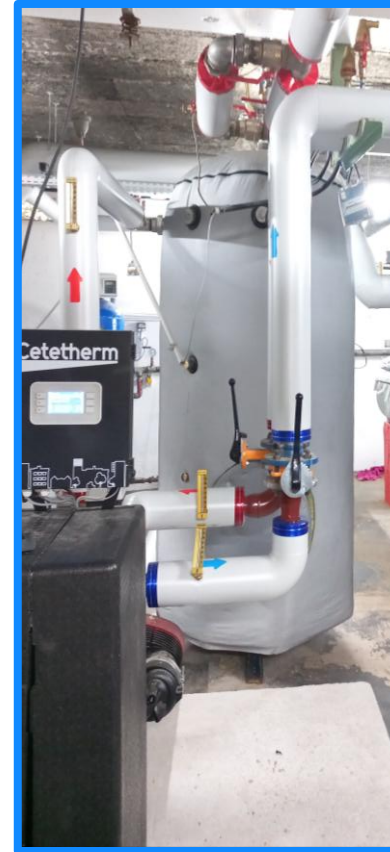
Remplacement des préparateurs ECS A2 B01 B15 U07 U10
