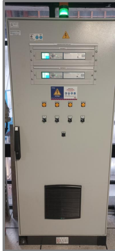
Remplacement de la centrale de détection gaz
