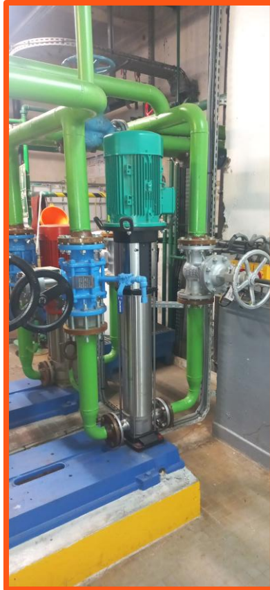
Remplacement de l'ensemble : Pompe variateur N°2 Et maintien de pression
