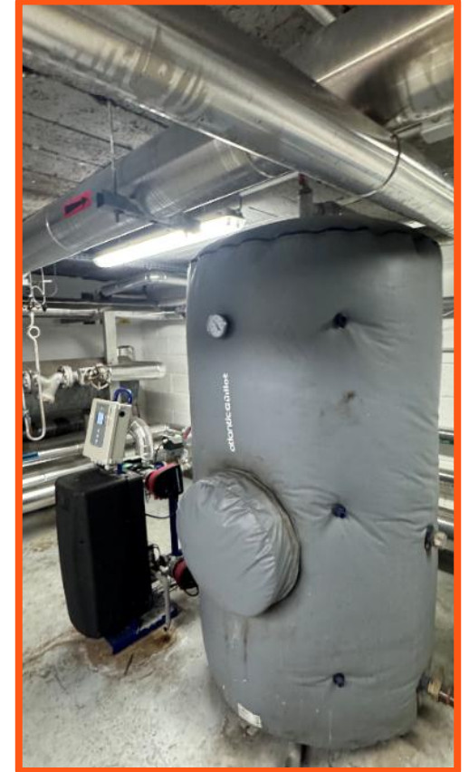
Entretien des échangeurs primaires, nettoyage et désinfection de l'ensemble des productions ECS
