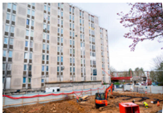
Chantier en cours
